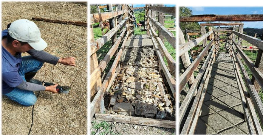
Construcción pisos en cemento para brete y Bascula. Reserva La Llanada.
