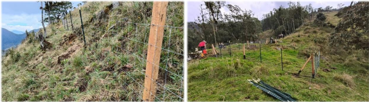
Construcción Cercados en Malla Ovejera
